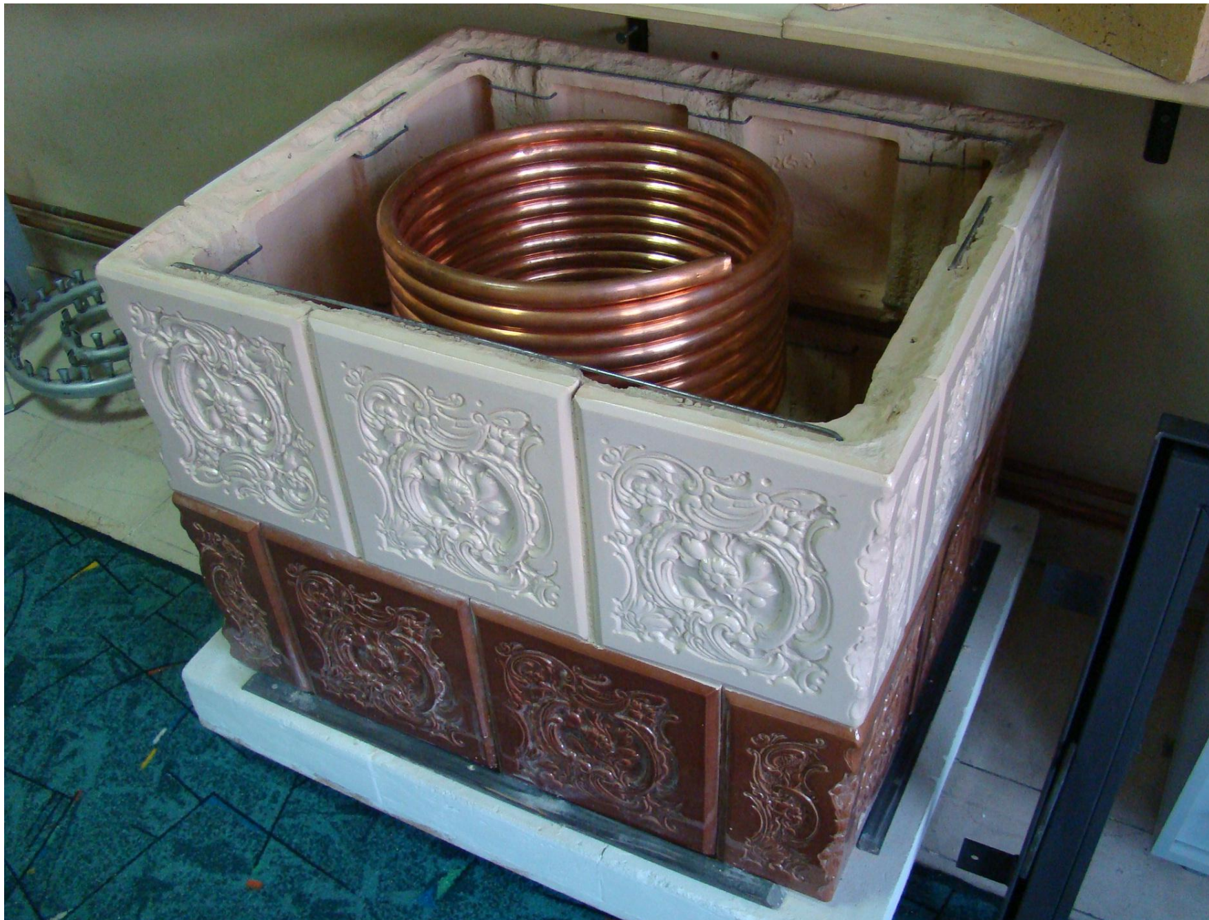
“Mehanizam” koji je glavni izvor topline kaljeve peći.
